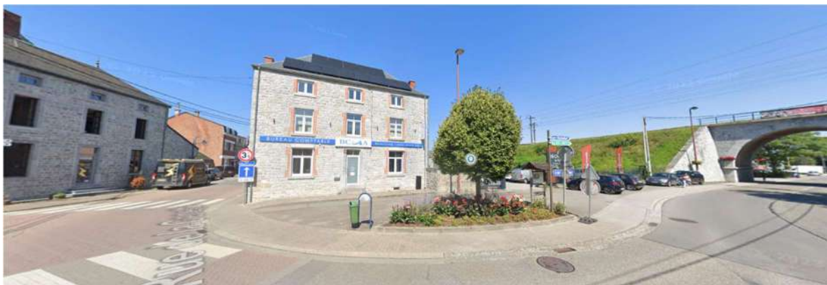
Photo 75 : Placette entre la rue de Rochefort et la rue de la Genette
