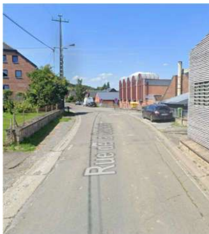
Absence de trottoir rue de la Couture
