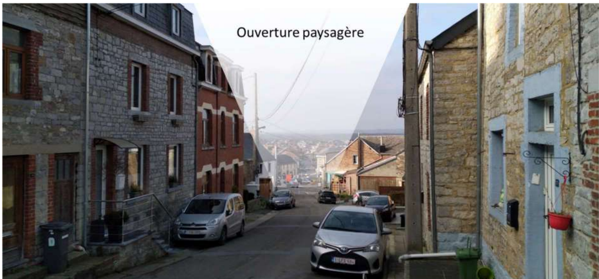
Photo 18 : Ouverture paysagère depuis la rue du Luxembourg
