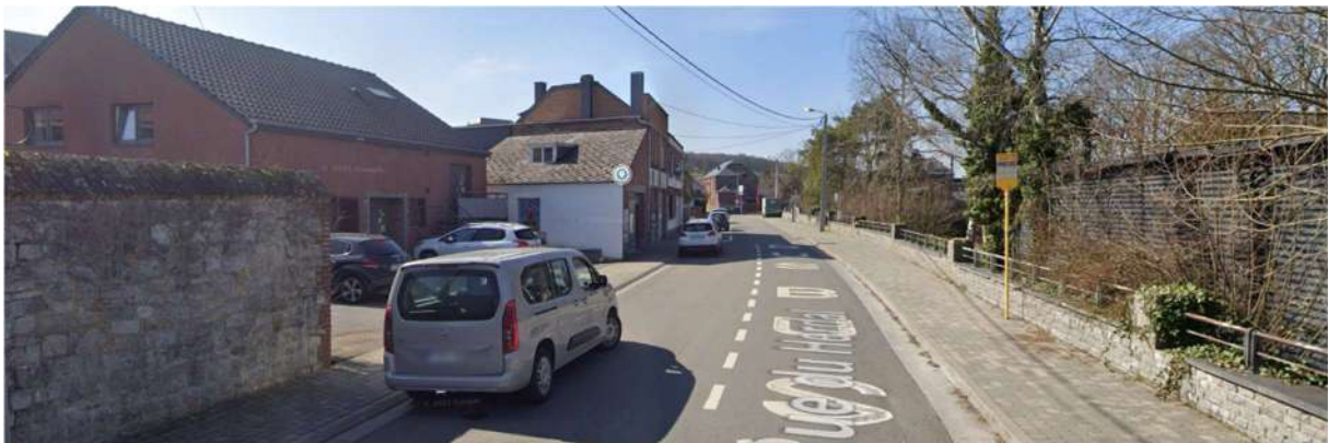
Photo 62 : Rue du Herdal
