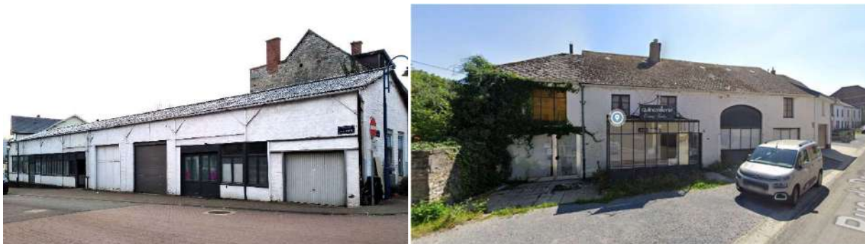
Photo 23 : Bâtiments désaffectés rue de Berry (bâtiment au croisement Berry-Genette et ancienne Quincaillerie)
