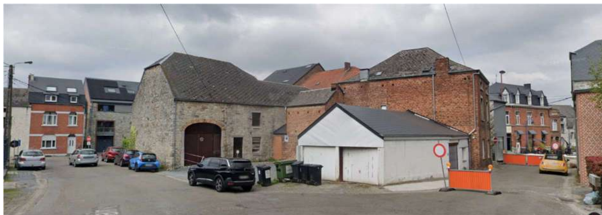
Photo 24 : Îlot de la Fontaine formé de garages, d'un bâtiment désaffecté et d'un logement
