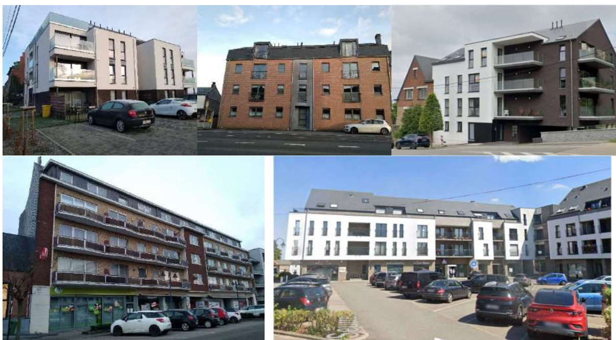
Photo 28 : Nouveaux immeubles à appartements dans la rue de Berry, la rue de Dinant et l'Allée du Nondeux (au-dessus) et immeubles à appartements entourant la place de Seurre (en-dessous)
