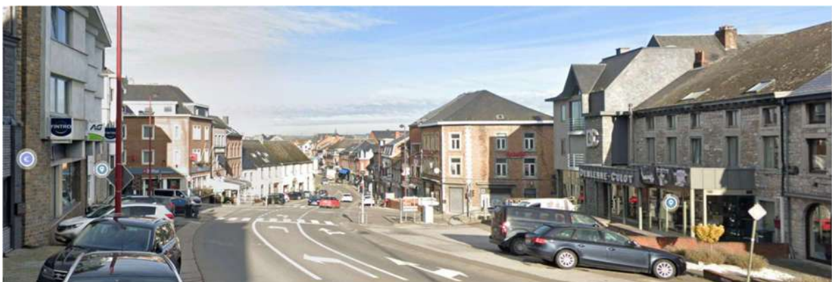
Photo 43 : Rue de Bouillon juste avant le carrefour à feu avec la rue de Rochefort et la rue des Ardennes
