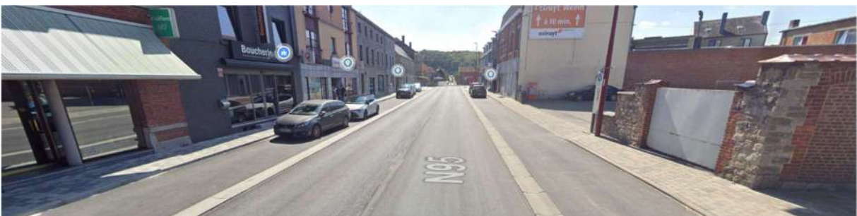
Photo 35 : Rue de Dinant entre le carrefour avec la rue du Herdal et la cacahuète (nouveaux aménagements de 2023)
