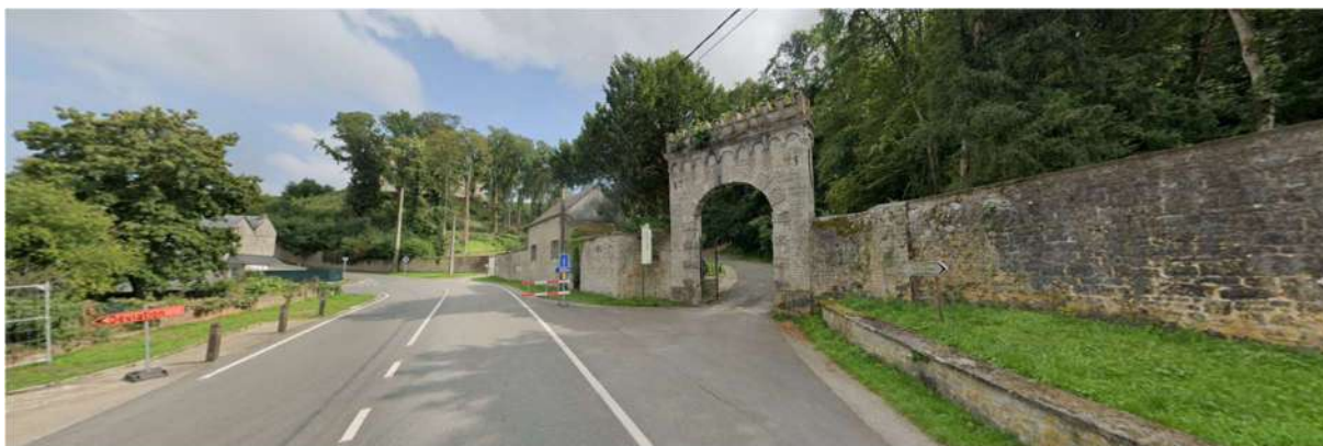
Photo 52 : Rue des Ardennes au niveau de l'entrée du parc
