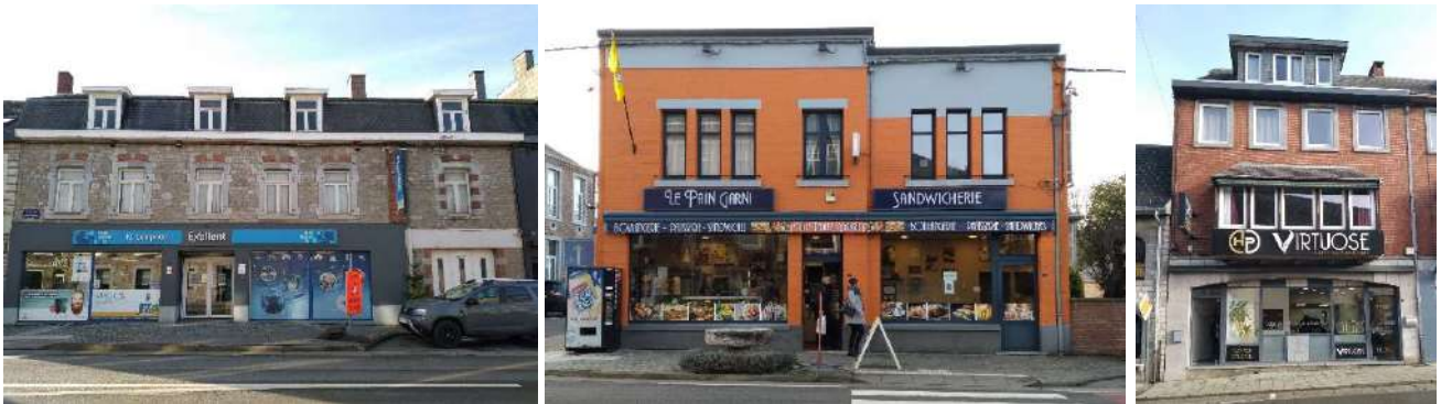
Photo 20 : Exemple de bâtiment avec commerce en rez et logement aux étages (rue de Dinant et rue de Bouillon)
