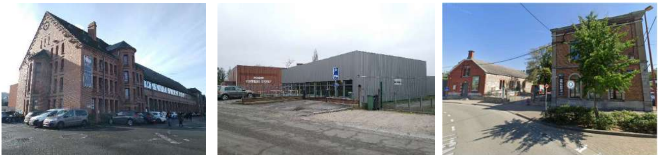
Photo 21 : Exemple de bâtiments affectés aux services publics (École des Frères, Centre sportif et Centre culturel)
