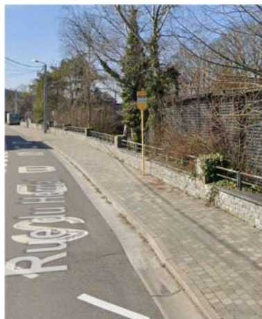
Trottoir rue du Herdal
