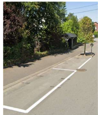
Trottoir Allée du Nondeux
