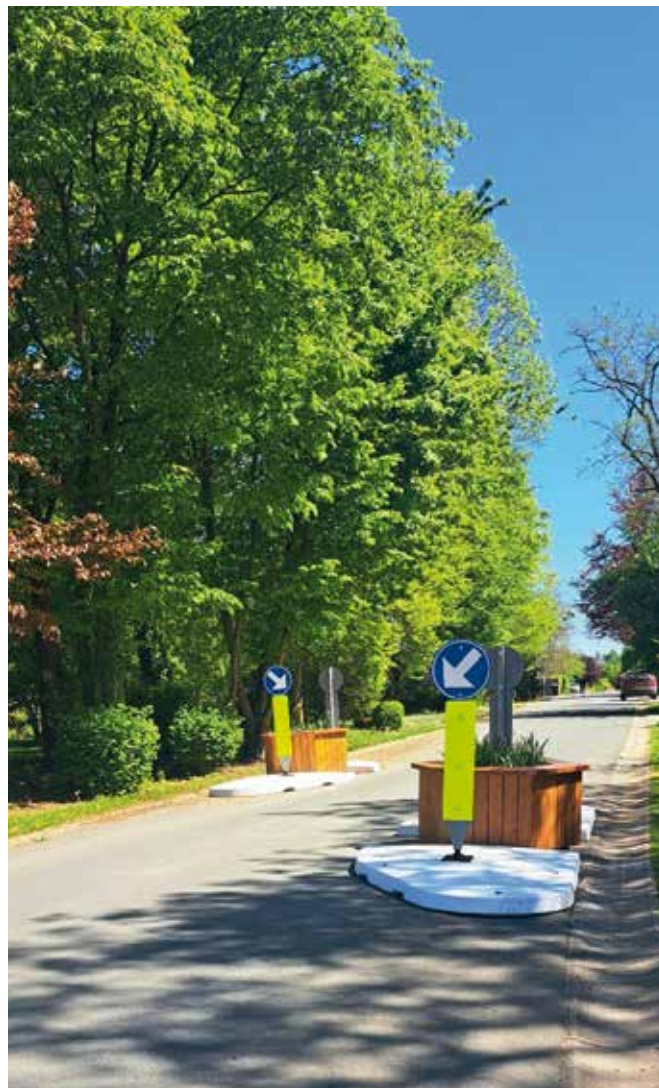
Rue du Luxembourg : installation de dispositifs de ralentissement avec 5 chicanes
