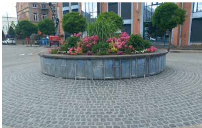
Place de Seurre : réfection du rond-point
