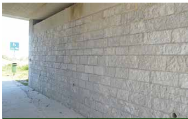
Rue du pape : sablage des murs du pont ferroviaire
