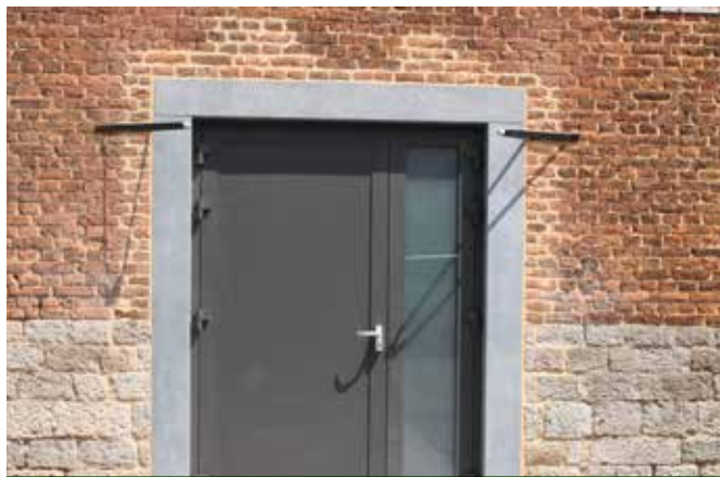
Winenne : réalisation d'une entrée PMR et pose du tarmac pour le parking de l'église
