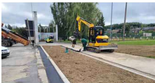
Finitions des travaux (abords, clôtures, peintures, aménagements...) dans le nouveau bâtiment de l'ATL
