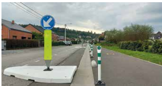
Sécurisation de la piste cyclable dans la rue de l'aubépine à Beauraing
