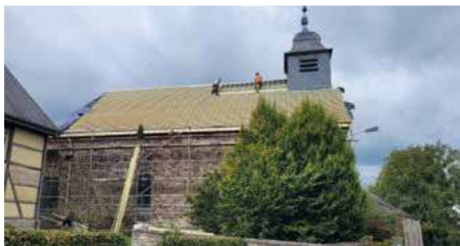
Réfection du toit de l'Eglise de Wancennes
